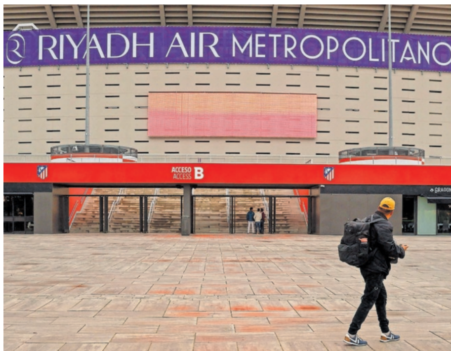
Vista del exterior del estadio Riyadh Air Metropolitano. EFE
